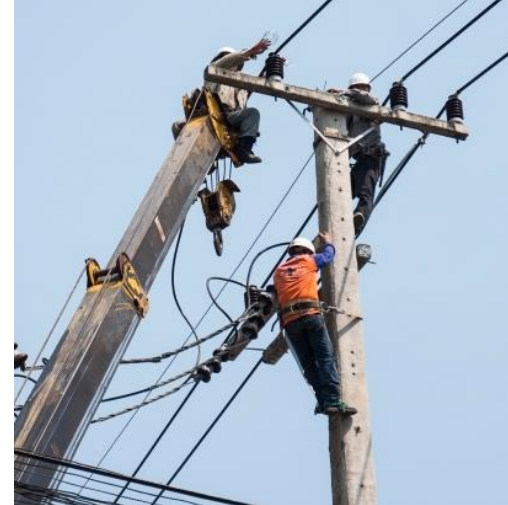
Budowa linii napowietrznej 220 kV SDTES do stacji 220 kV „Zafarobod”
