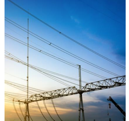
Budowa linii napowietrznej 110 kV oraz części konstrukcyjnej stacji 110/35/10 kV „Suffa” zgodnie z projektem farmy wiatrowej turystyczno-rekreacyjnej strefy „Zomin”
