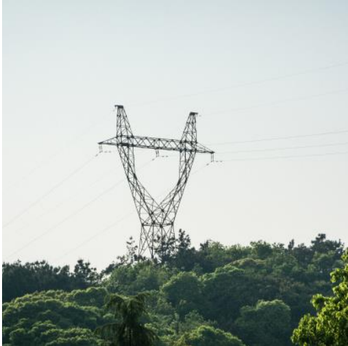
Budowa trzech jednotorowych linii napowietrznych 220 kV SS 220 kV Nishanskaya SFES-ORU 220 kV Elektrociepłownia Talimarjan
