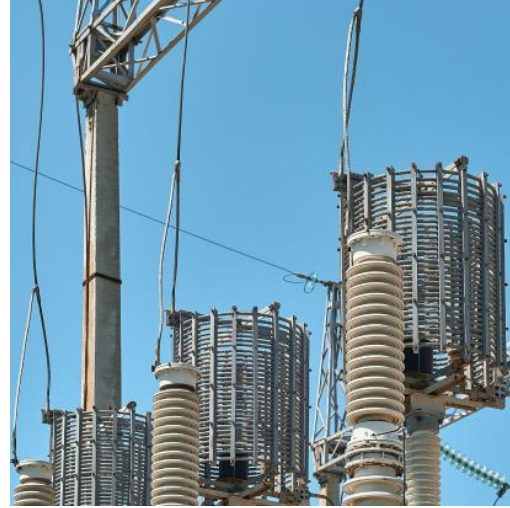
Budowa linii napowietrznej 500 kV w stacji Surkhan – podstacja Khoja – Alvan (przez terytorium Republiki Uzbekistanu)
