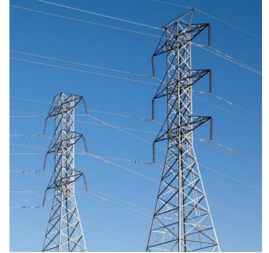
Budowa napowietrznej linii elektroenergetycznej 110 kV na farmie wiatrowej, specjalnego węzła przemysłowego, inżynierii mechanicznej i urządzeń elektrycznych w regionie Andiżan
